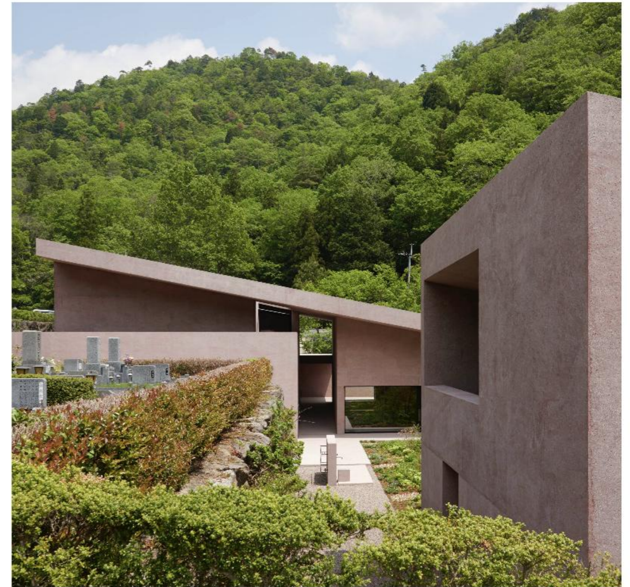
Construidos con hormigón armado en un tono rojo terroso, la capilla y el centro de visitantes son las aportaciones de Chipperfield al Inagawa Cemetery, en Hyogo (Japón).
